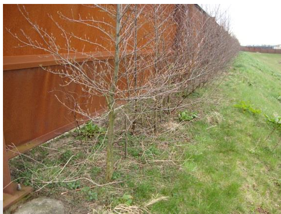
Foto: Jonge aanplant die op termijn mogelijk tot schade kan leiden.
